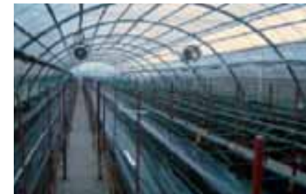
De bogen van deze kas zijn koud verbogen, waardoor een kettinglijn-koepel is ontstaan.
