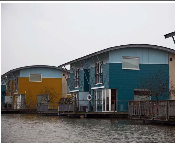
(Afb. 5) In Maasbommel bevinden zich 46 Amfibische woningen. Bij een normale waterstand bevinden deze woningen zich op palen, maar bij een hoge waterstand maken ze zich los van de palen, en drijven ze op het water.
