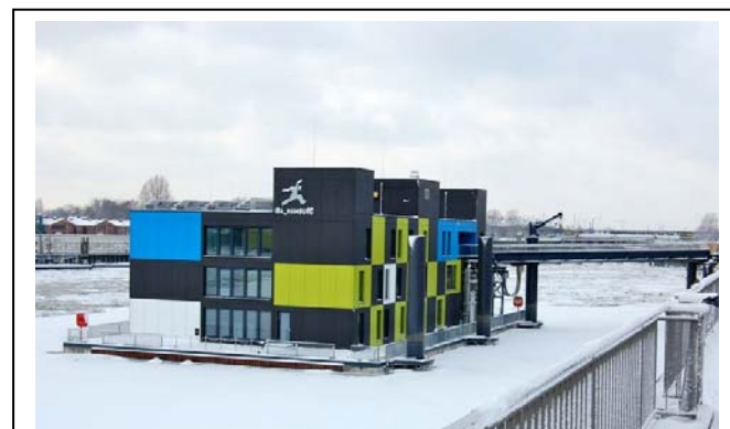
(Afb. 23) In de haven van Hamburg ligt de IBA Dock, die als expositiegebouw van nieuwe bouwtechnieken dient.
