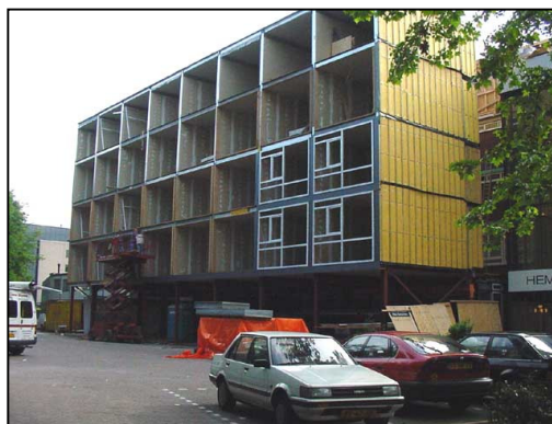
Afb. 13.10 Bouw van het HEM- hotel in Amsterdam. In dit hotel is ook een staalfarme-vloer met een zwevende dekvloer toegepast.
