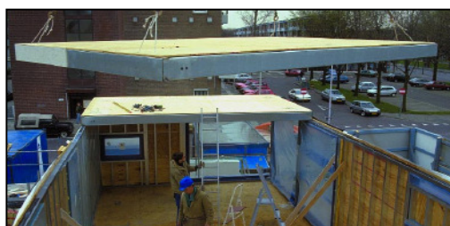
Afb. 13.11. Een element van een staalfarme-vloer.
