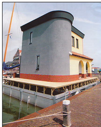
Afb. 15.2. Drijvend huis in Volendam, gebouwd met alternatieve materialen. De muren zijn gemaakt van EPS blokken.
